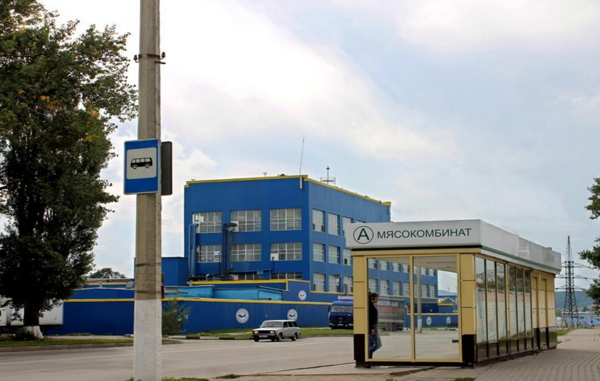
Мясокомбинат . Район Крейда г.Белгород, ул.Ватутина,83 А
