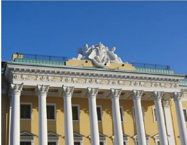
Композиция на фото-тоже работа Легкобита, реставрация с заменой гипсового материала, на полиэфирную смолу.
