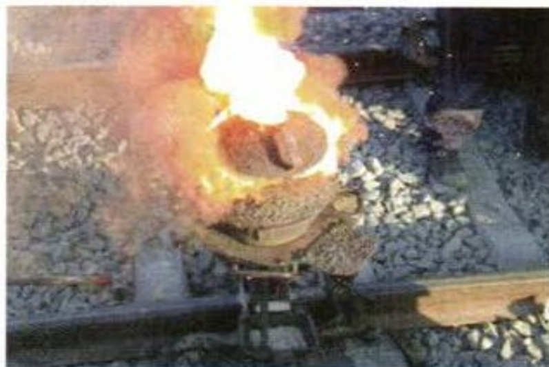
Рис. 42. Сваривание рельса алюминотермией (а); рельс, сваренный с использованием алюминотермии (б)
