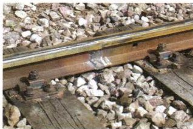
Рис. 42. Сваривание рельса алюминотермией (а); рельс, сваренный с использованием алюминотермии (б)
