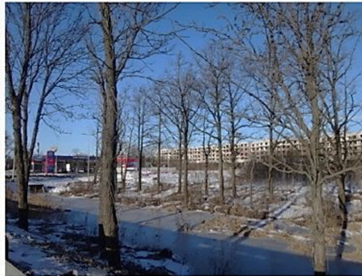
Вид на возведенные черные корпуса «Планетограда» сквозь зеленые насаждения (март 2018)
