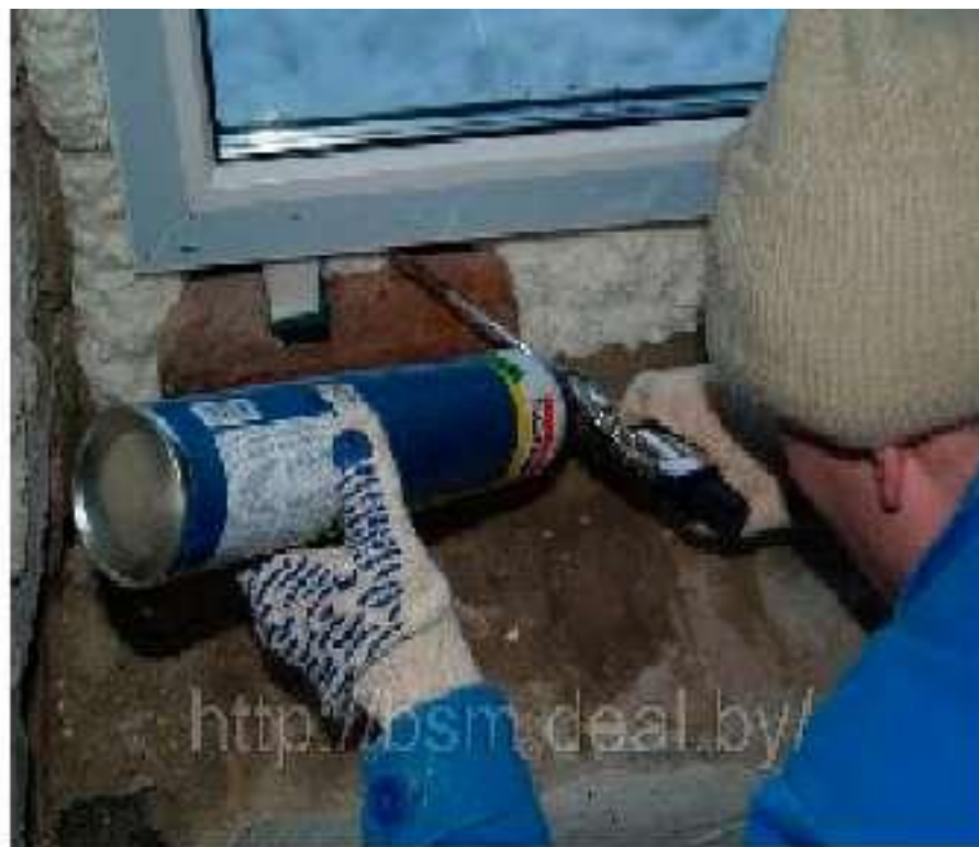
Заполнение стыка монтажной пеной
