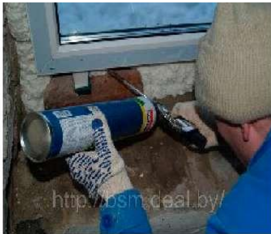
Заполнение стыка монтажной пеной
