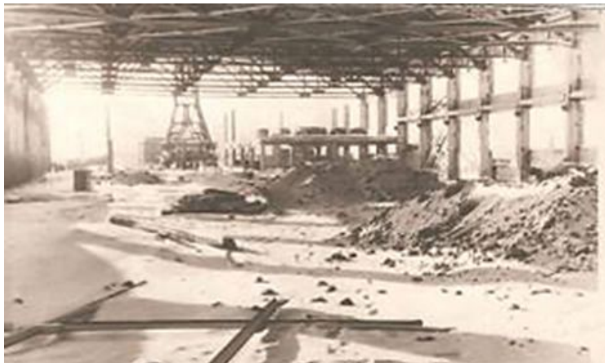
Строительство гимнастического манежа
