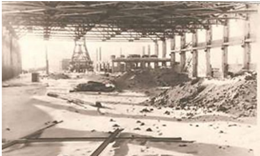
Строительство гимнастического манежа
