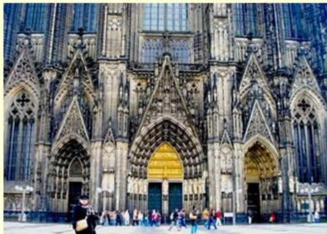
Кёльн. Фасад Домского собора.
