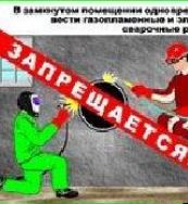
В ЗАКРЫТЫХ ПРОСТРАНСТВАХ ОДНОВРЕМЕННО ЗАПРЕЩАЮТСЯ ГАЗОВАРЯТЕЛЬНЫЕ И ЭЛЕКТРОСВАРОЧНЫЕ РАБОТЫ
