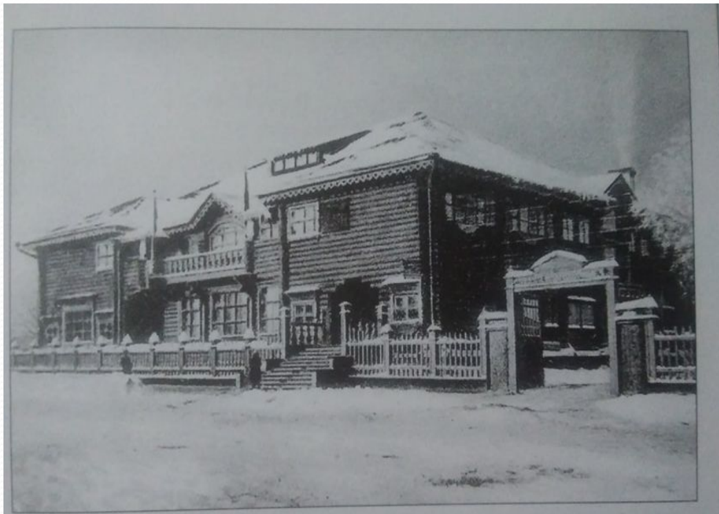
Дом крестьянина до реконструкции. Фото 1930. Архив Б. Бойцова
