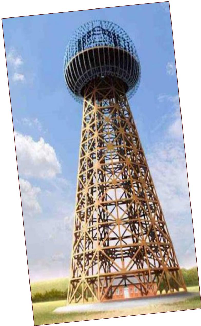
Главным сооружением была каркасная башня высотой 57 метров с огромной медной «тарелкой» наверху – гигантским усилительным передатчиком. И со стальной шахтой, углубленной в землю на 36 метров.
