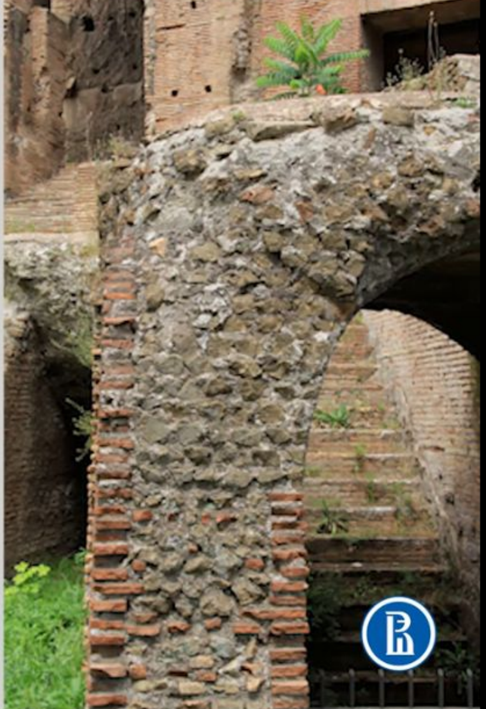
Бетонная стена Колизея. wikipedia.org 80 г.
