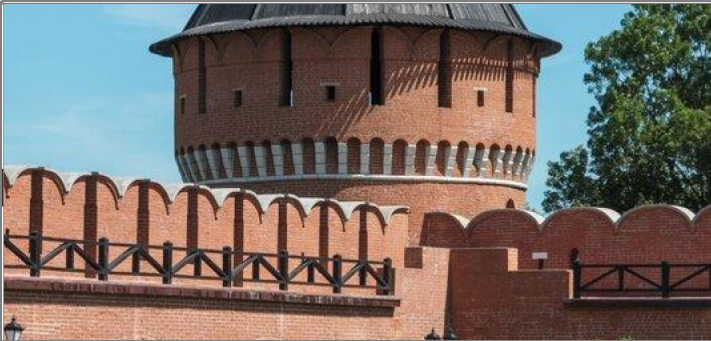
Угловая Ивановская башня(Тайницкая)
