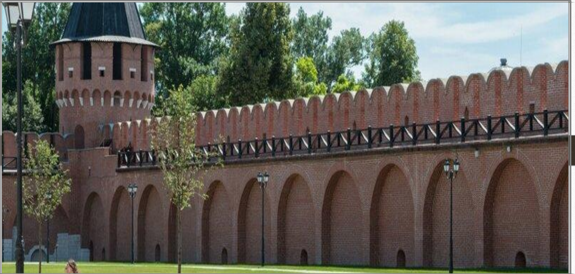
Никитская башня и кремлёвская стена с внутренней стороны
