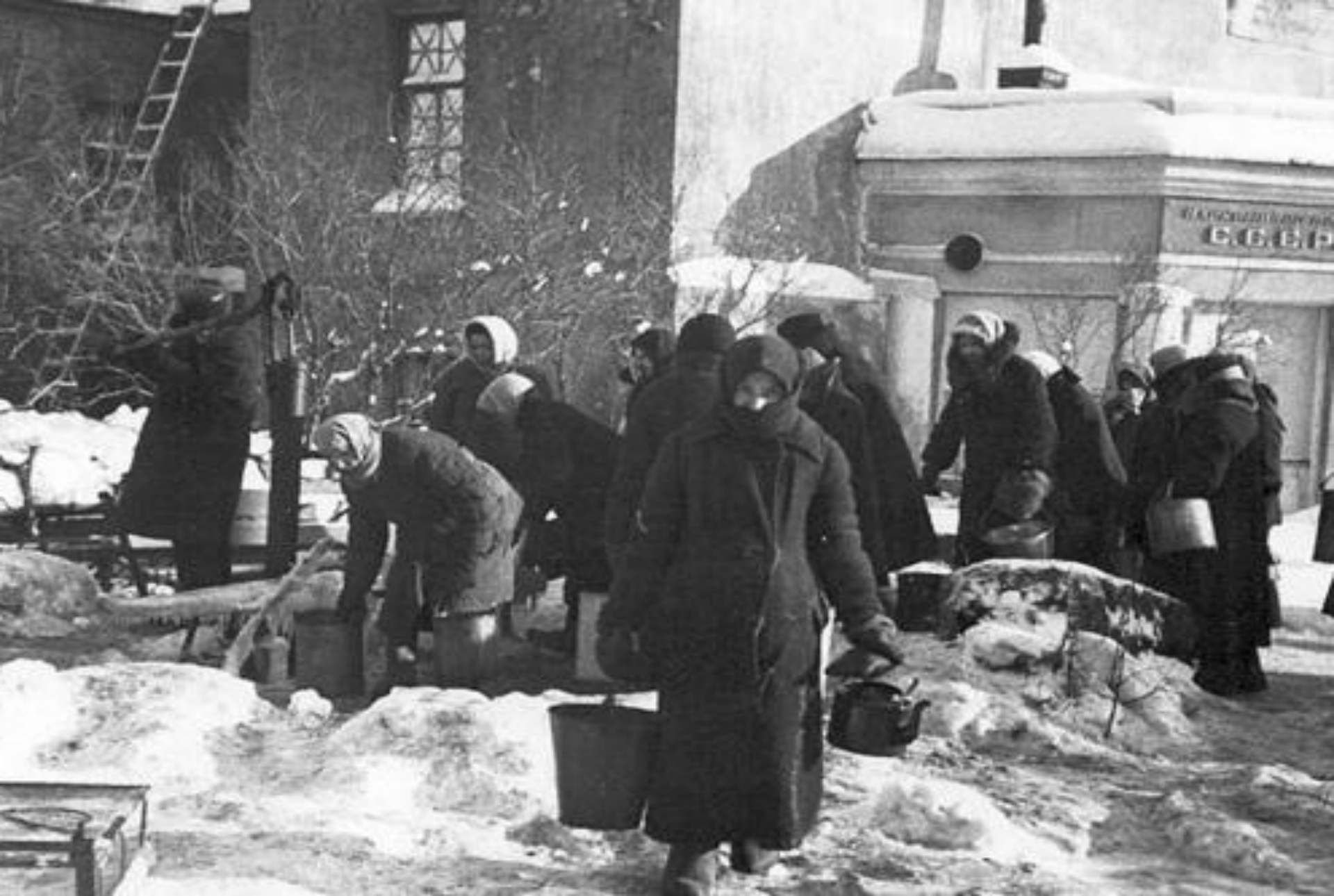
У водоразборной колонки, установленной на углу ул. Дзержинского и Загородного проспекта. 05. 02.1942 г.
