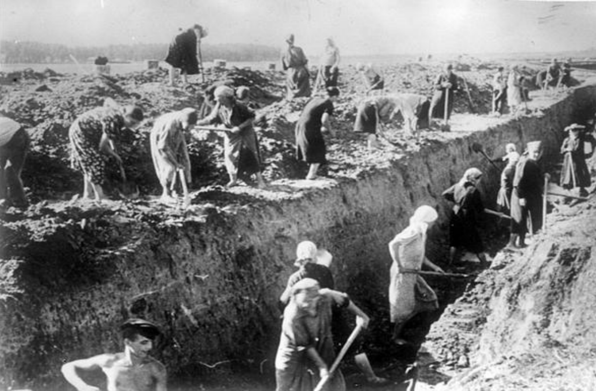
Жительницы прифронтовых деревень на строительстве оборонительных сооружений. Июль 1941 г.
