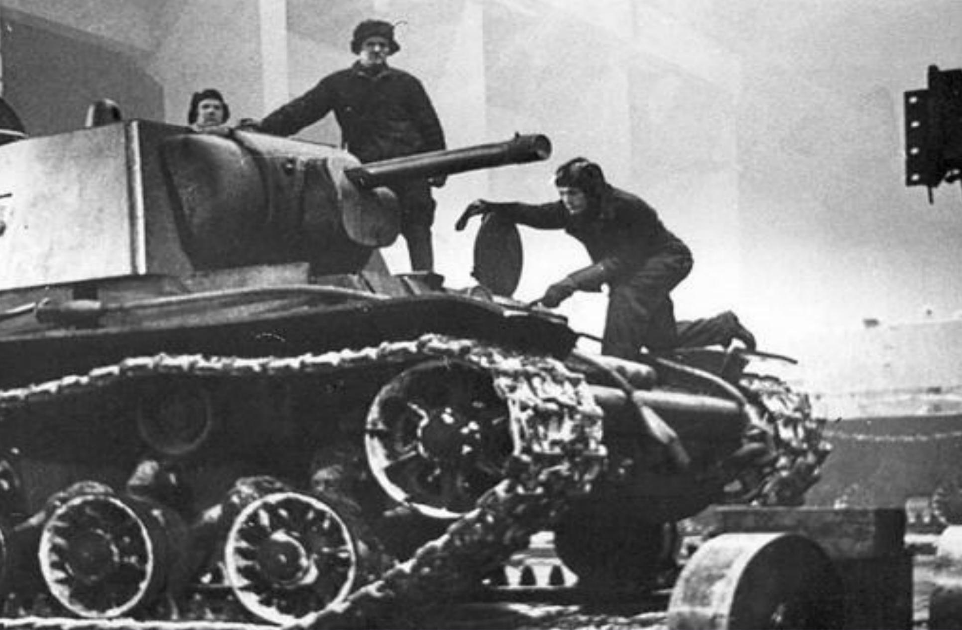
**На базе гидротурбинного цеха Металлического завода им. Сталина по чертежам Кировского завода было налажено производство танков "KV". ;1942 г.**
