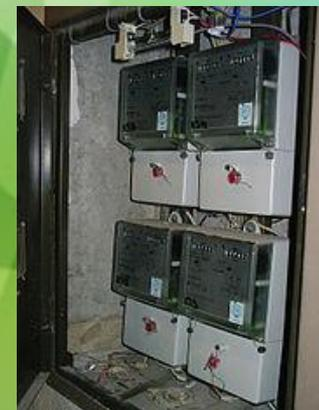
Для учёта активной и реактивной электроэнергии переменного тока служат индукционные одно- и трёхфазные приборы, для учёта расхода электроэнергии постоянного тока — электродинамические счётчики. Число оборотов подвижной части прибора, пропорциональное количеству электроэнергии, регистрируется счётным механизмом.
