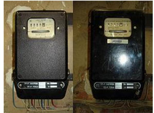
По конструкции: **ИНДУКЦИОННЫМ**
