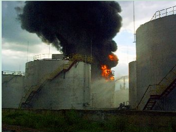
Пожар на нефтеперерабатывающем заводе.
