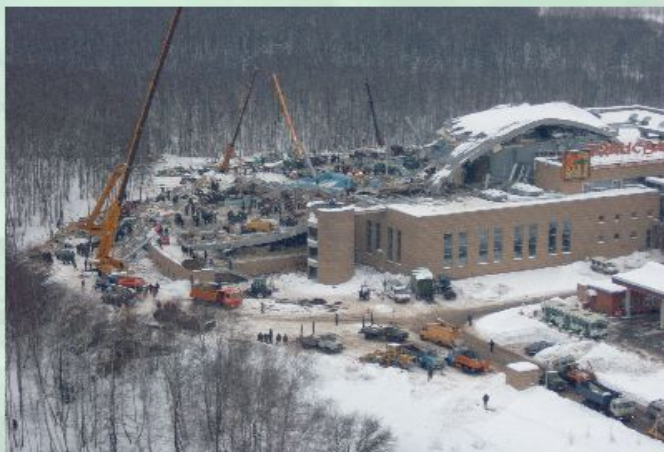
Последствия обрушения аквапарка «Трансвааль парк». г. Москва.
