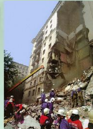
Последствия взрыва газа в жилом доме.
