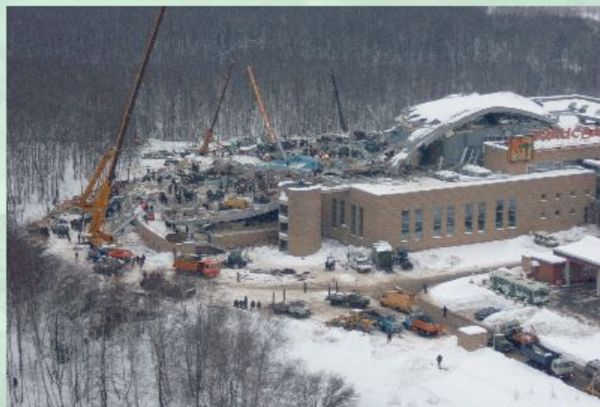
Последствия обрушения аквапарка «Трансвааль парк». г. Москва.
