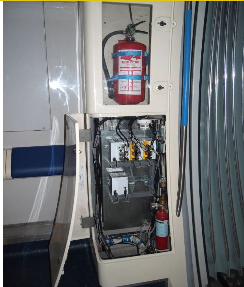
Шкаф (передний) левый – для размещения противоузово́й системы.
