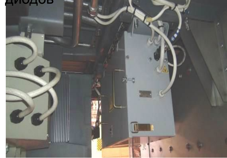
БРД-блок диодов разделительных
