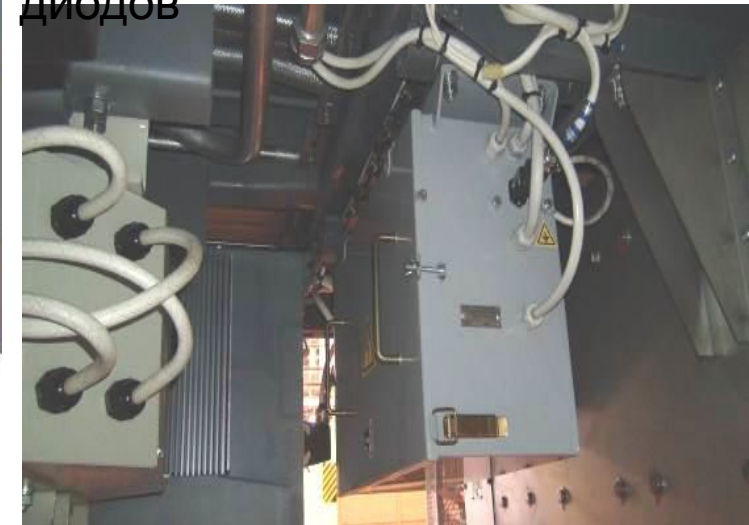
БРД-блок диодов разделительных
