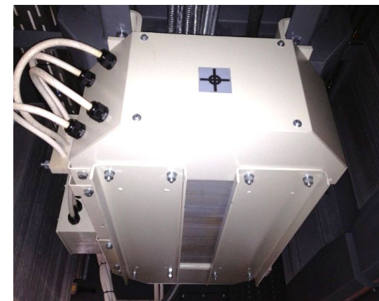
Реактор сетевого фильтра. Кроме
