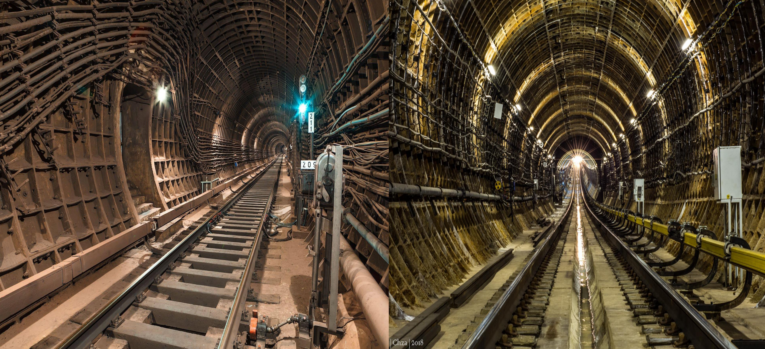
Главные пути (перегон) линии
