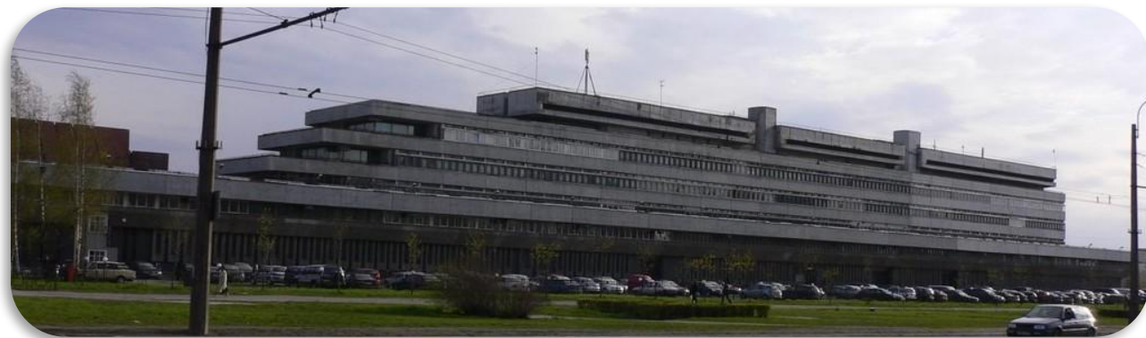
КОРПУС «У» - Ленинский проспект, дом 101
