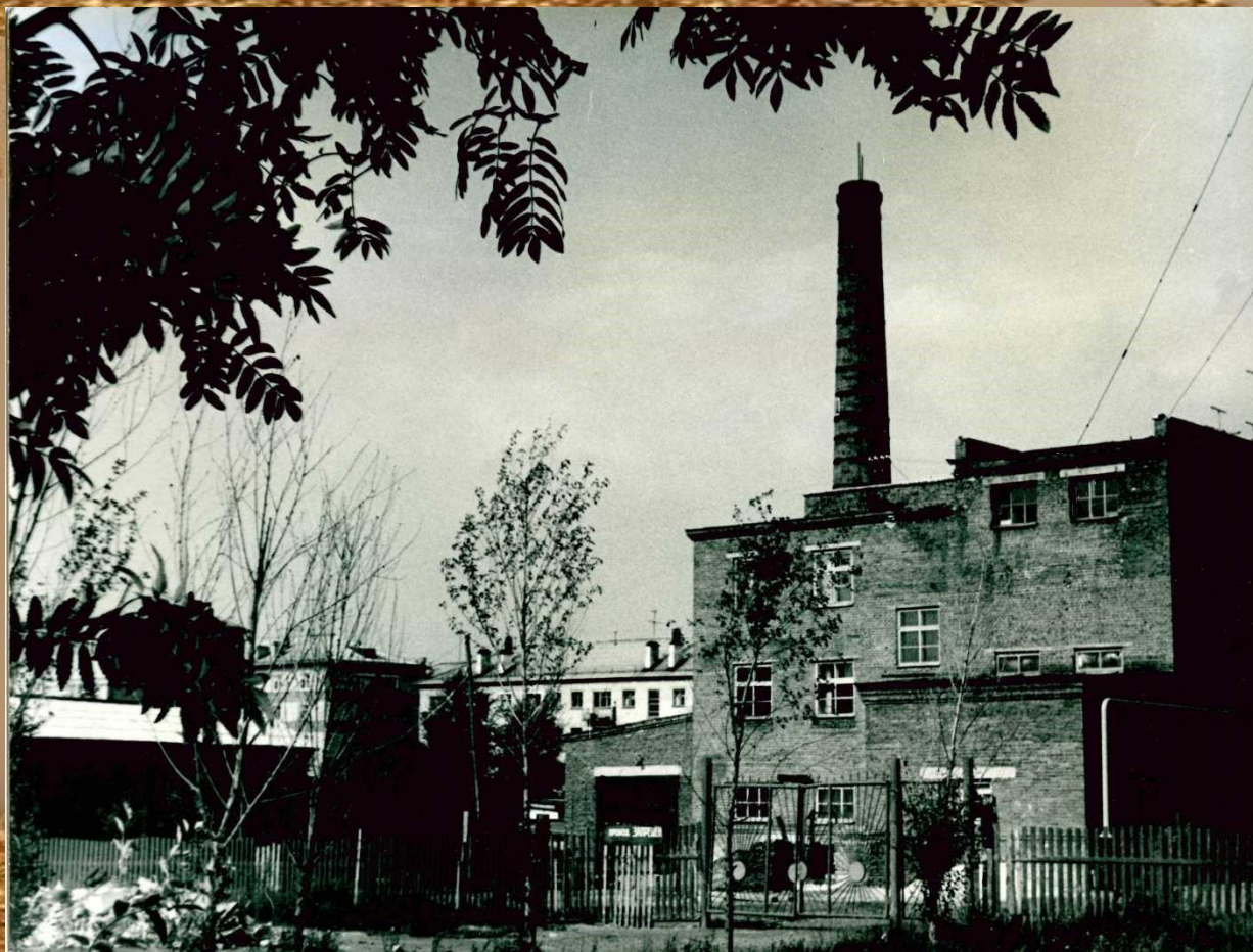
Первая в городе газовая котельная
