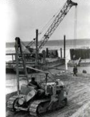
Строительство Краснодарского водохранилища
