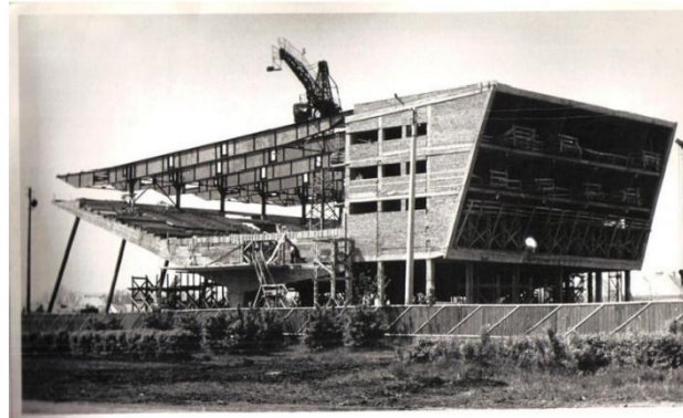
СТРОИТЕЛЬСТВО КИНОТЕАТРА "АВРОРА"
