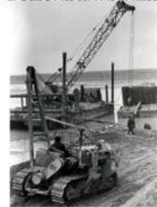
Строительство Краснодарского водохранилища
