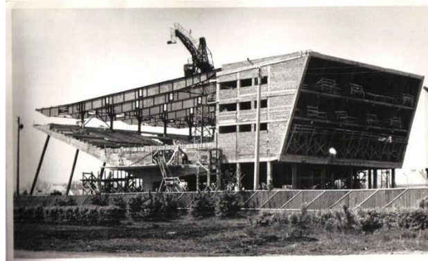
СТРОИТЕЛЬСТВО КИНОТЕАТРА "АВРОРА"
