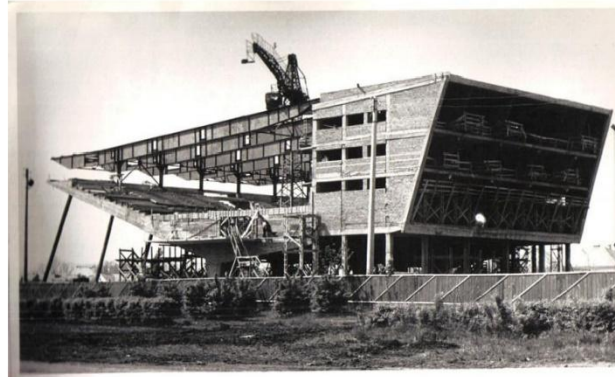
СТРОИТЕЛЬСТВО КИНОТЕАТРА "АВРОРА"
