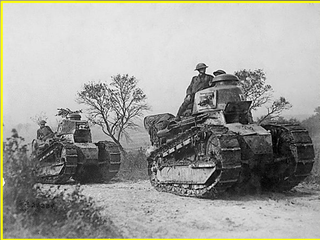
*Французы разработали и запустили в производство очень удачный лёгкий танк Рено FT-17. Он имел вращающуюся башню с установленной в ней лёгкой пушкой или пулемётом.*
