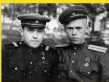
Август 1946 год. Тверская обл г. Вышний Волочек. Асфандияров, Герликов
