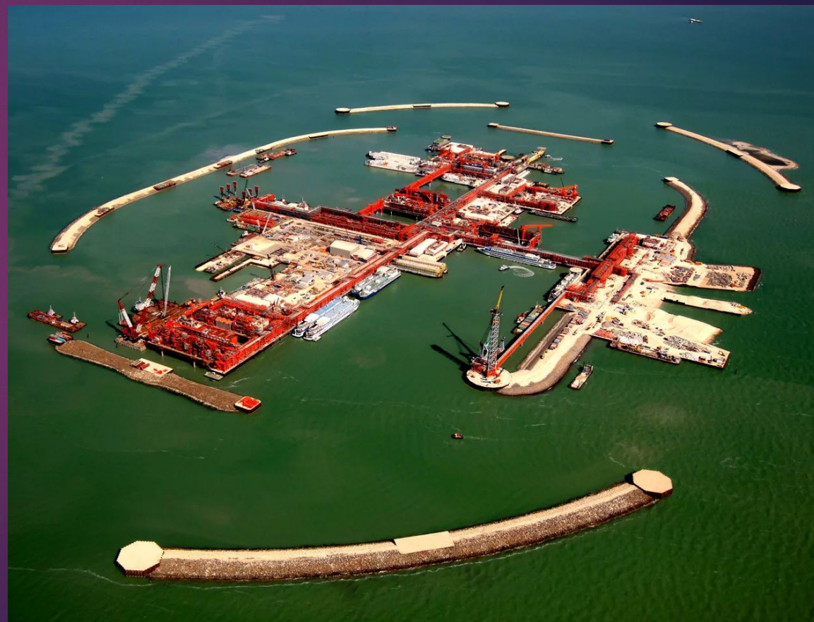
Рис. 6.16. Система насыпных островов для разработки Кашаганского месторождения
