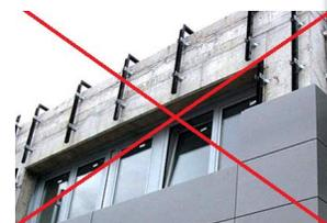
**Запрещён монтаж**, если облицовка здания не может подлежать демонтажу и доработке для изготовления технических вырезов и отверстий необходимые для инсталляции сплит - системы.
