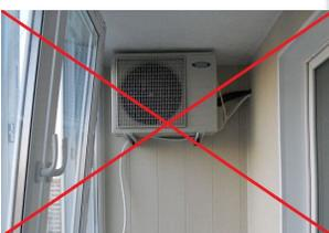
**Запрещена установка** внешнего блока в закрытых (не проветриваемых) помещениях (застекленный балкон, чердачные и мансардные перекрытия, закрытые шахты, лестничные проходы и т.п.).
