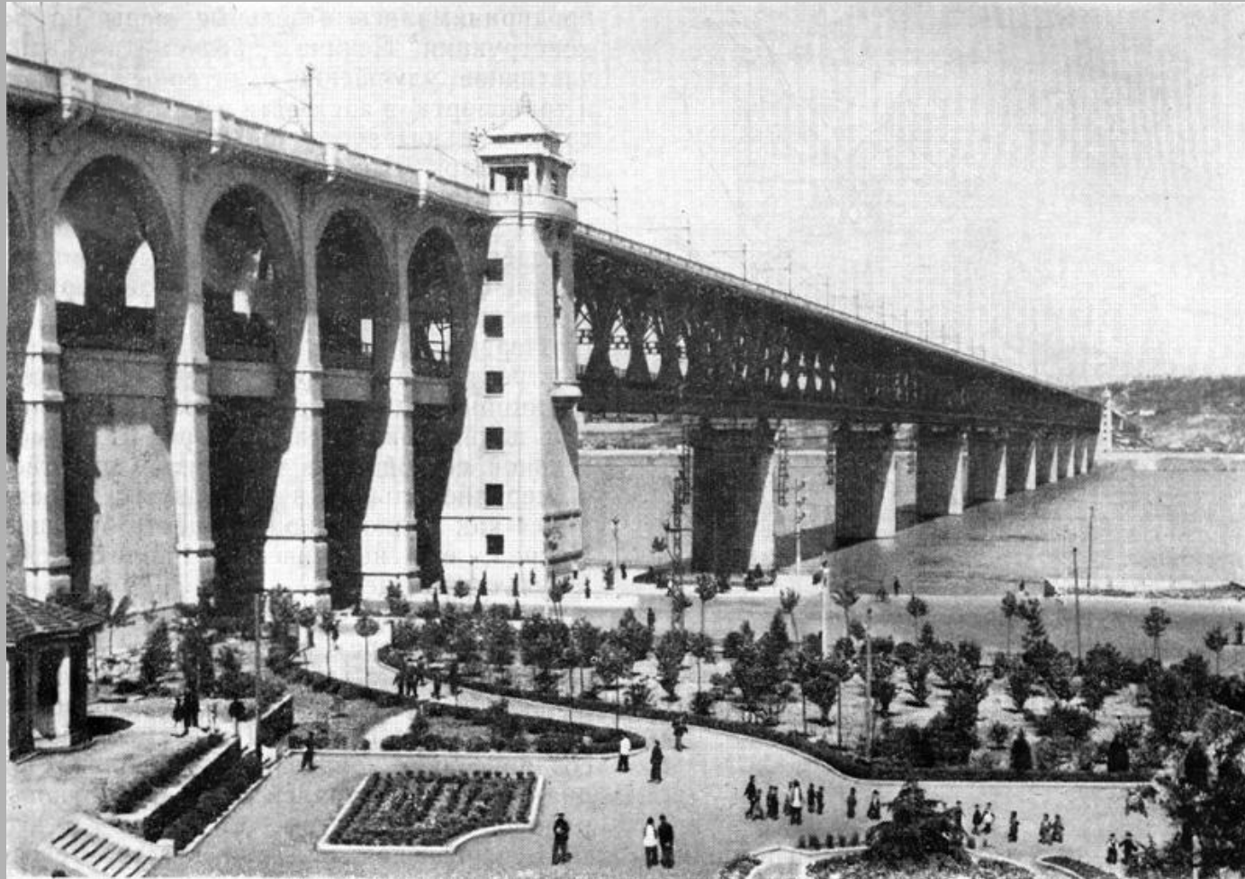
Ухань. Двухъярусный мост через р. Янцзы
