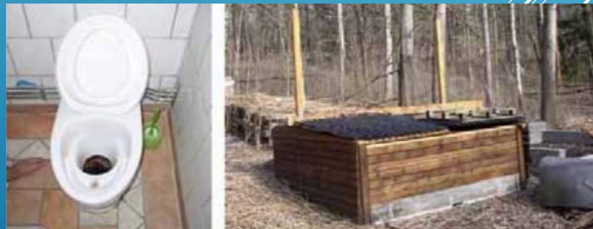
Мочеотводящая система с безводным сбором фекалий – фекалии в закрытой емкости компостируются вместе с травой и листьями
