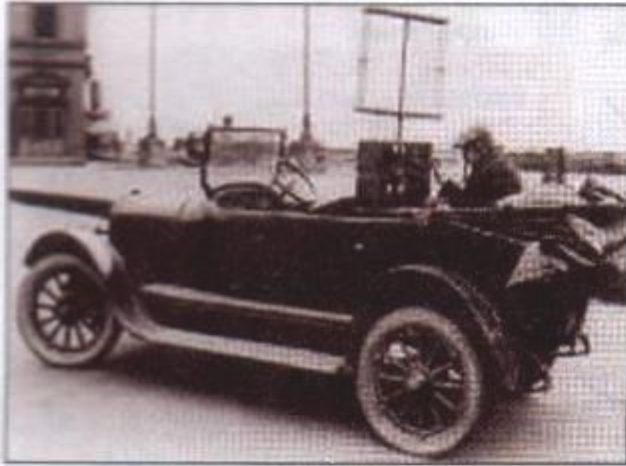
1925 год. Передвижная приемопередаточная станция американской BELL-лаборатории
