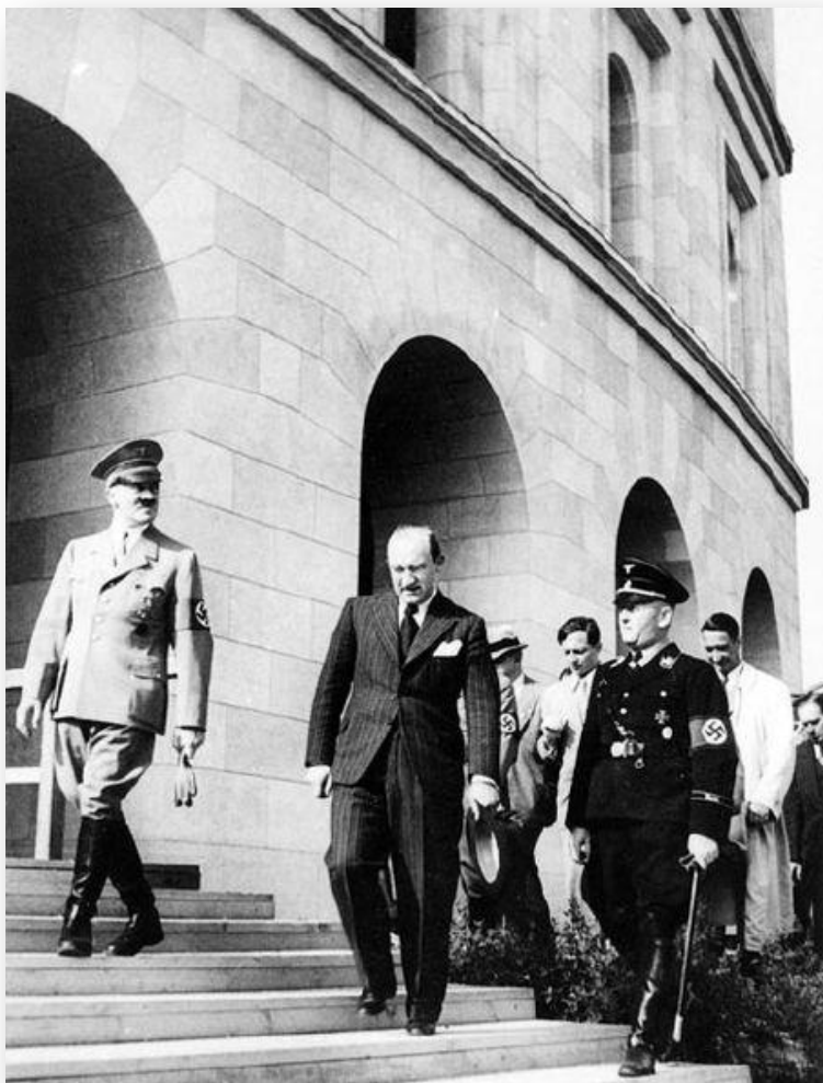
Гитлер и Франц Руфф при посещении стройплощадки Конгрессхалле, 1937
