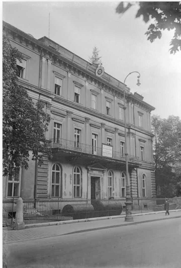
Коричневый дом после реконструкции 1930 г.
