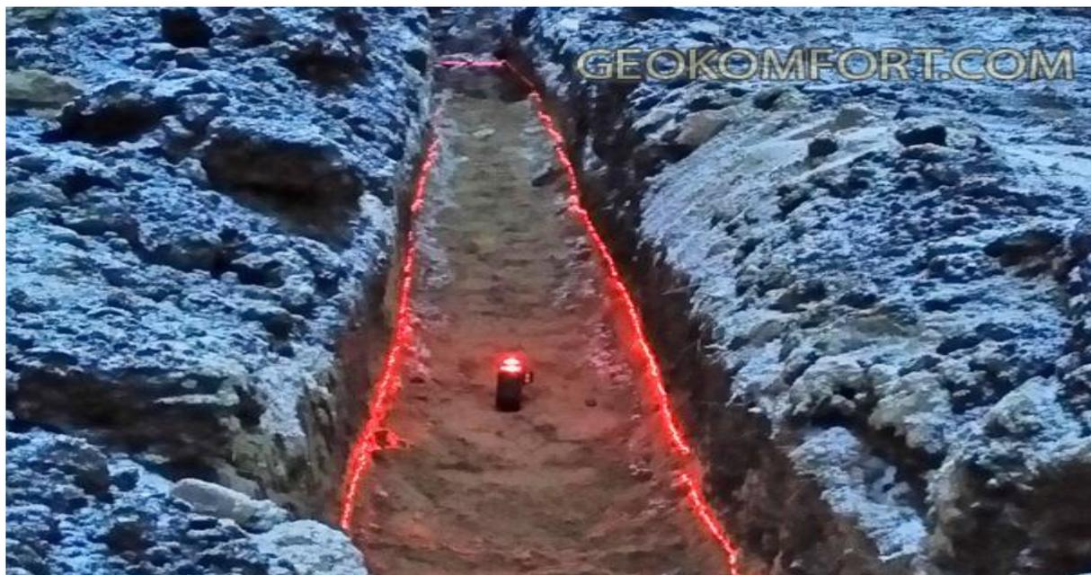
проверка уровня дренажной траншеи лазерным нивелиром
