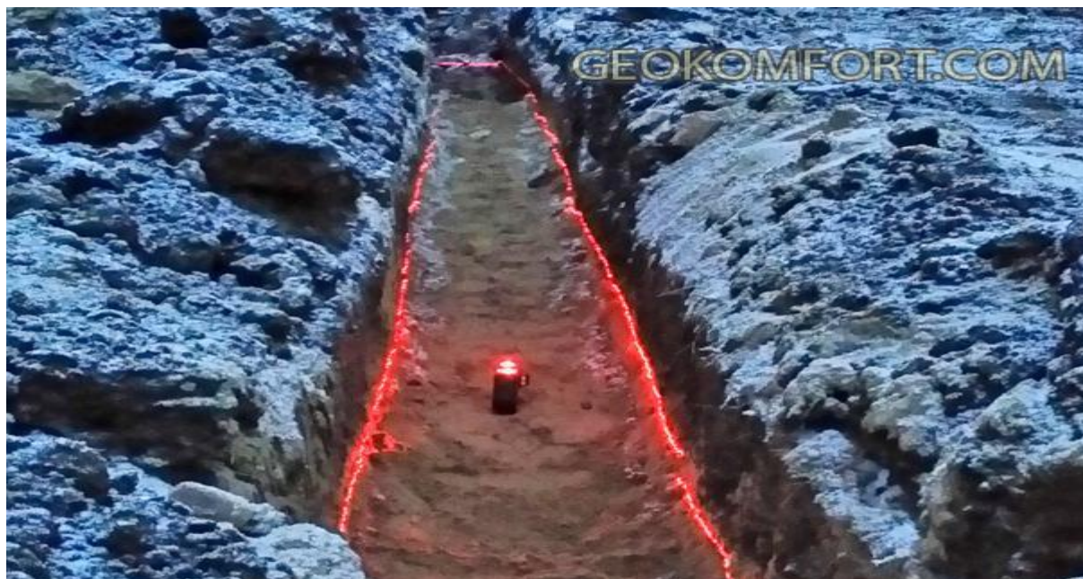
проверка уровня дренажной траншеи лазерным нивелиром
