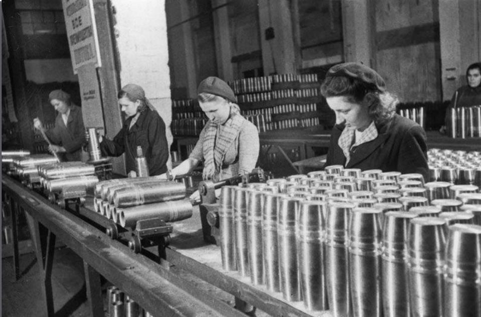
Изготовление снарядов и взрывателей для минометных снарядов
