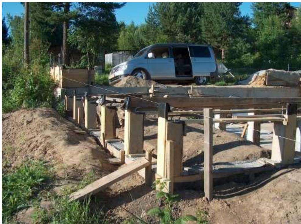
**Перекрестные ленты** (рис. д) - ленточные фундаменты, выполняемые в двух направлениях для выравнивания осадок отдельных колонн в ряду и здания в целом
