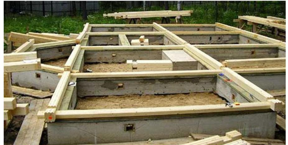
Рациональны при слабых неоднородных напластованиях (с  $R < 0,1$  МПа), поскольку такие фундаменты предотвращают неравномерные деформации.
