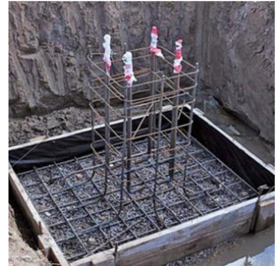
Подожву их можно развивать в длину и ширину. Отдельные фундаменты не увеличивают жесткость здания, их применяют, когда по расчету неравномерности осадки не превышают допустимых значений.
