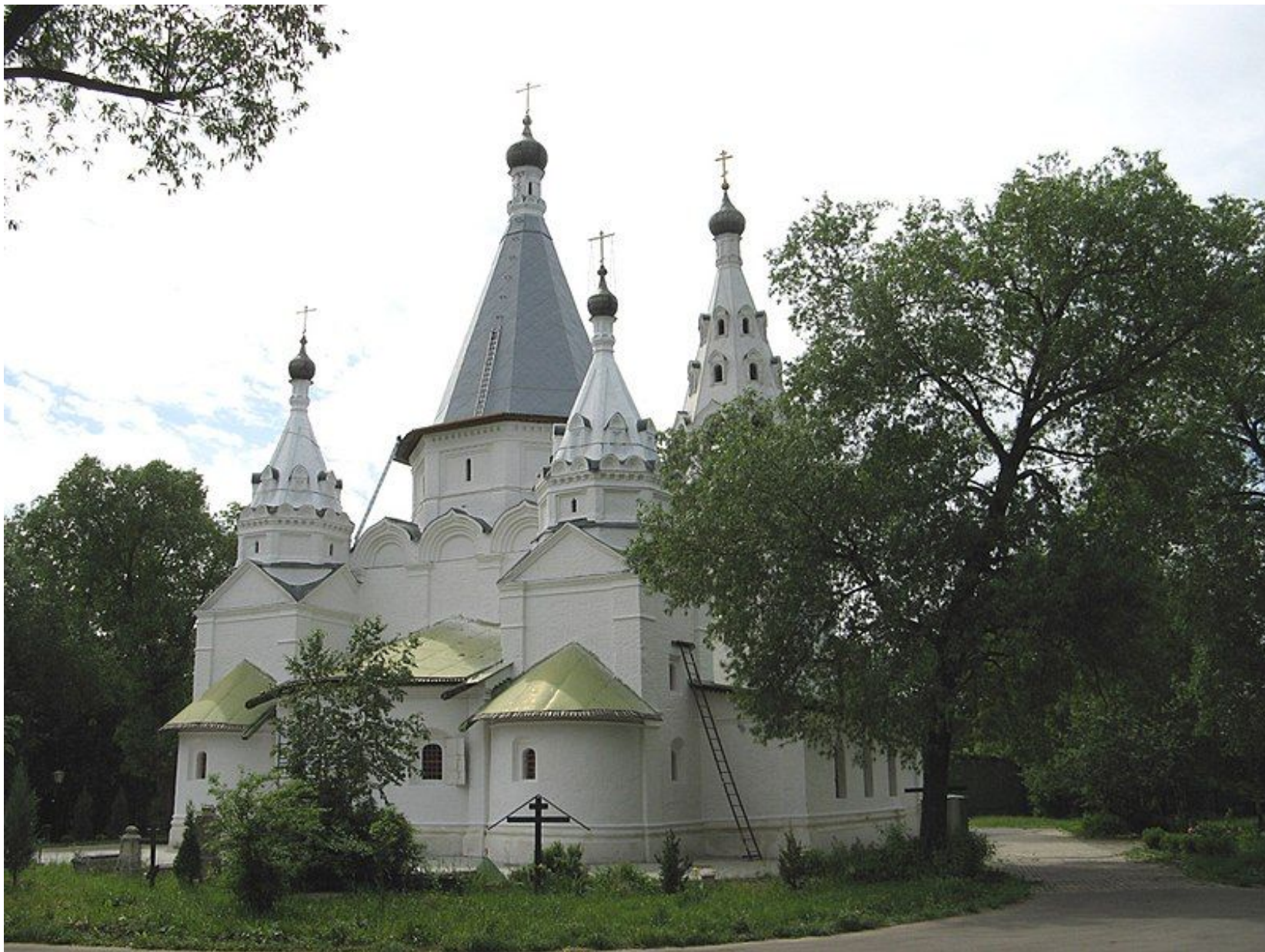
Церковь Живоначальной Троицы в Троицком-Голенищеве на реке Сетунь (1644 - 1645 гг.):
