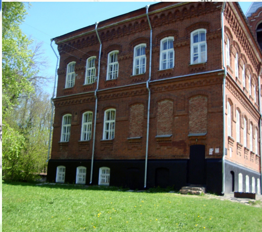
Вид с левой стороны здания
