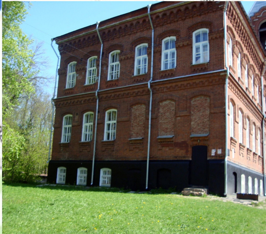
Вид с левой стороны здания
