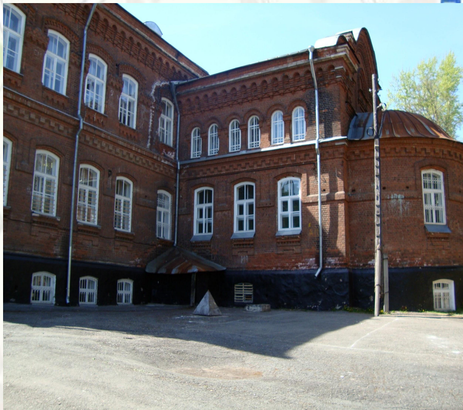
Вид с правой стороны здания
