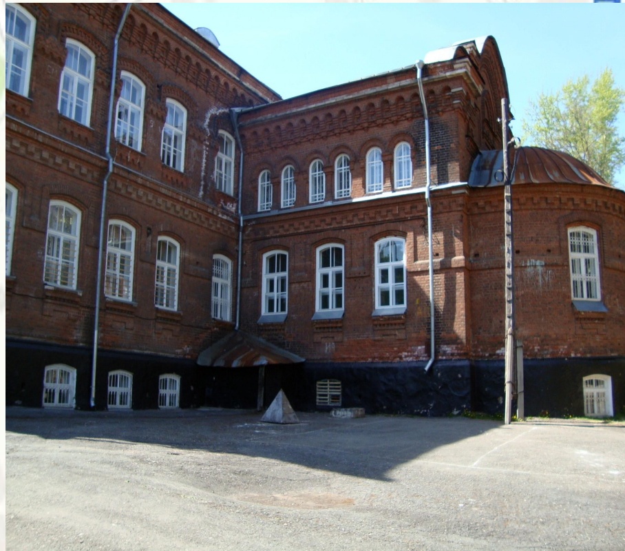
Вид с правой стороны здания
