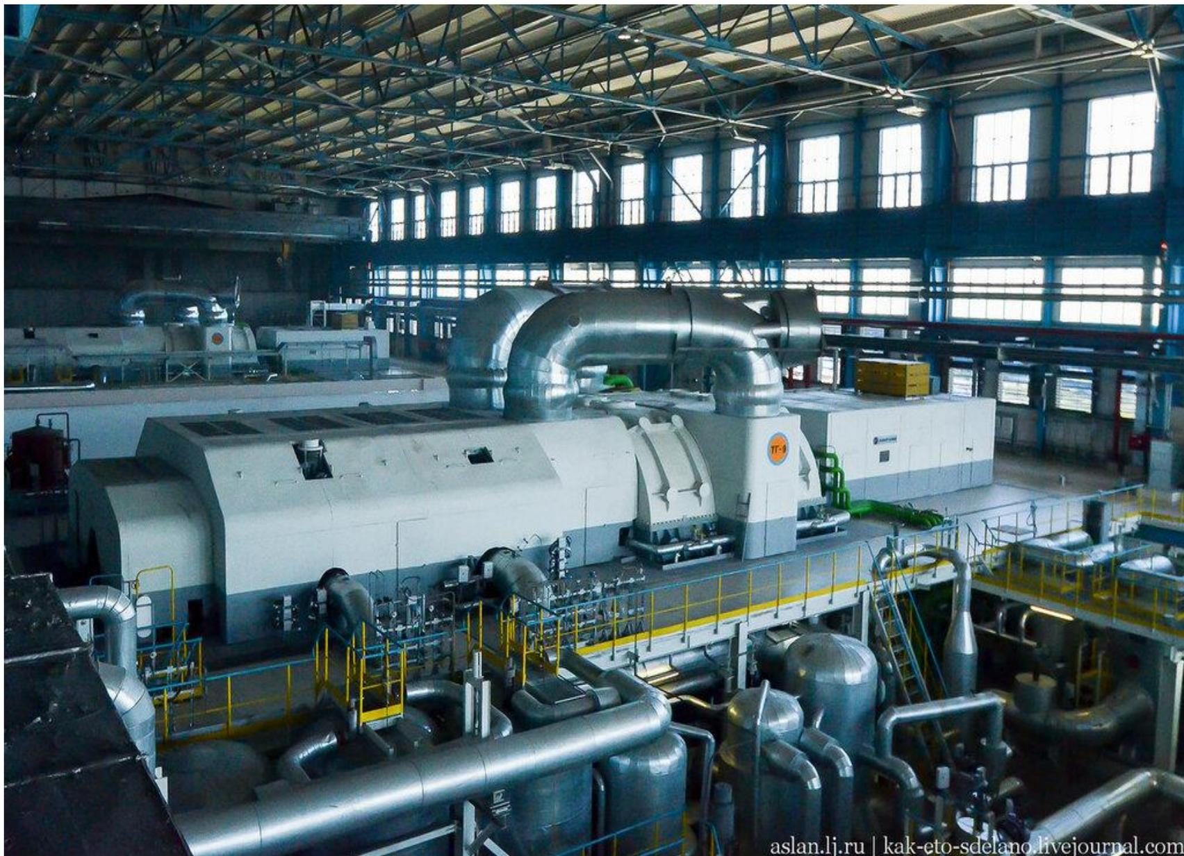
**Конденсационные** паровые турбины служат для превращения максимально возможной части теплоты пара в механическую работу. Они работают с выпуском (выхлопом) отработавшего пара в конденсатор, в котором поддерживается вакуум (отсюда возникло наименование).
