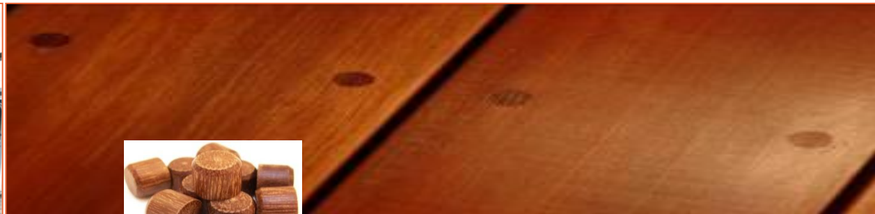
Сквозной крепеж с заглушками из той же породы дерева
