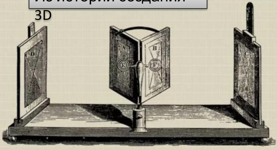
Зеркальный стереоскоп Уитстона
