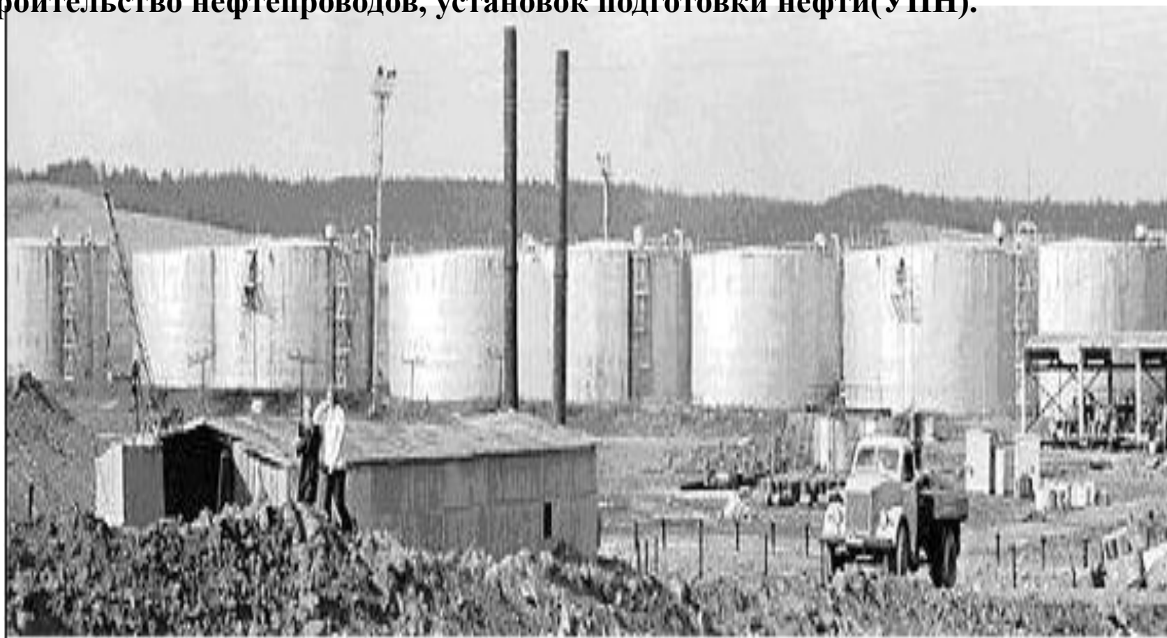
строительство Киенгопской УПН
