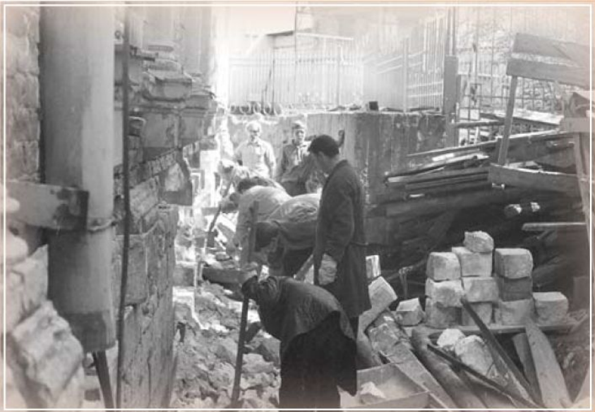
Расчистка цоколя храма. 1998 год.
