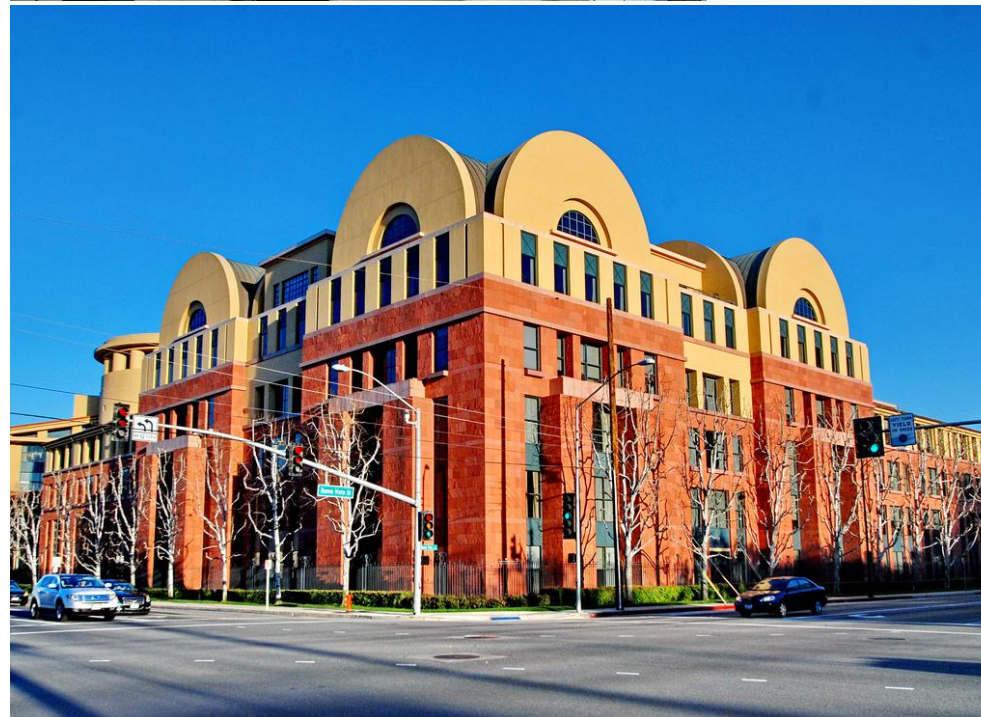
Главное здание студии The Walt Disney Company, Бербанк
