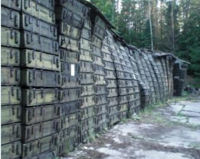
Нарушена устойчивость штабелей на 2-х открытых площадках
