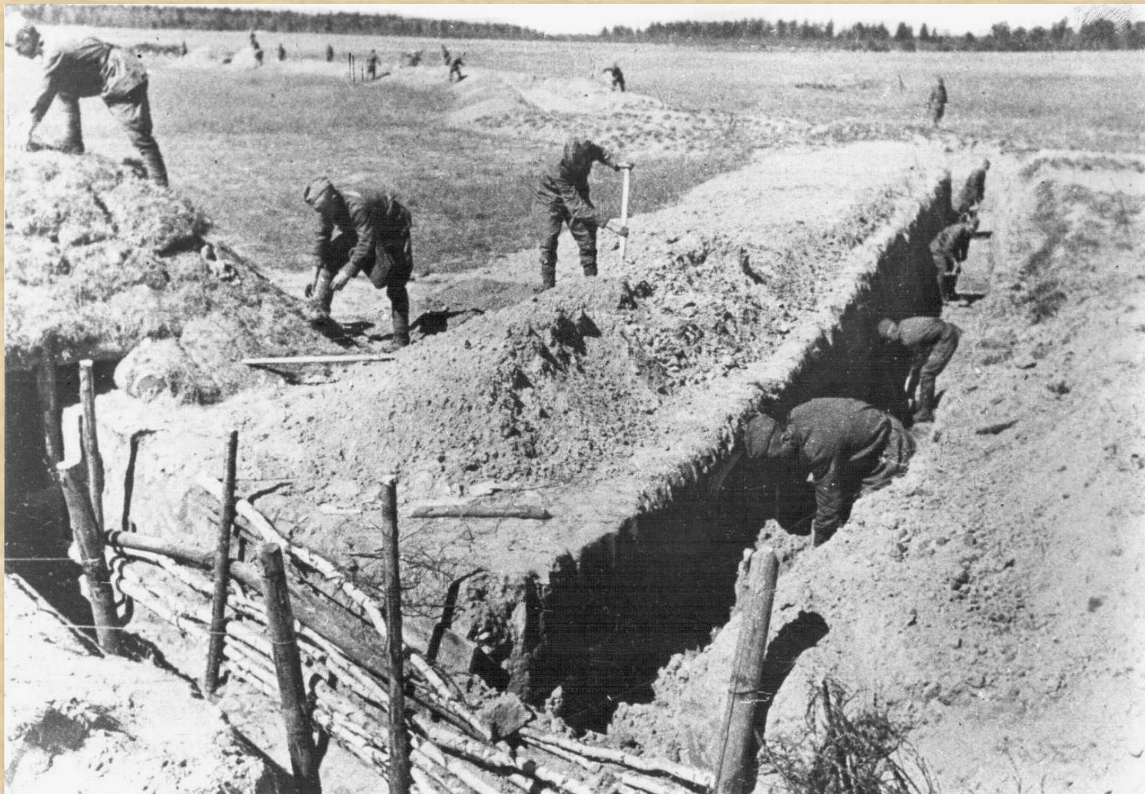
**Труженики рубежей перекапывали и копали землю, строили блиндажи, траншеи и противотанковые рвы. Самый длинный оборонительный рубеж построили за 45 дней.**
