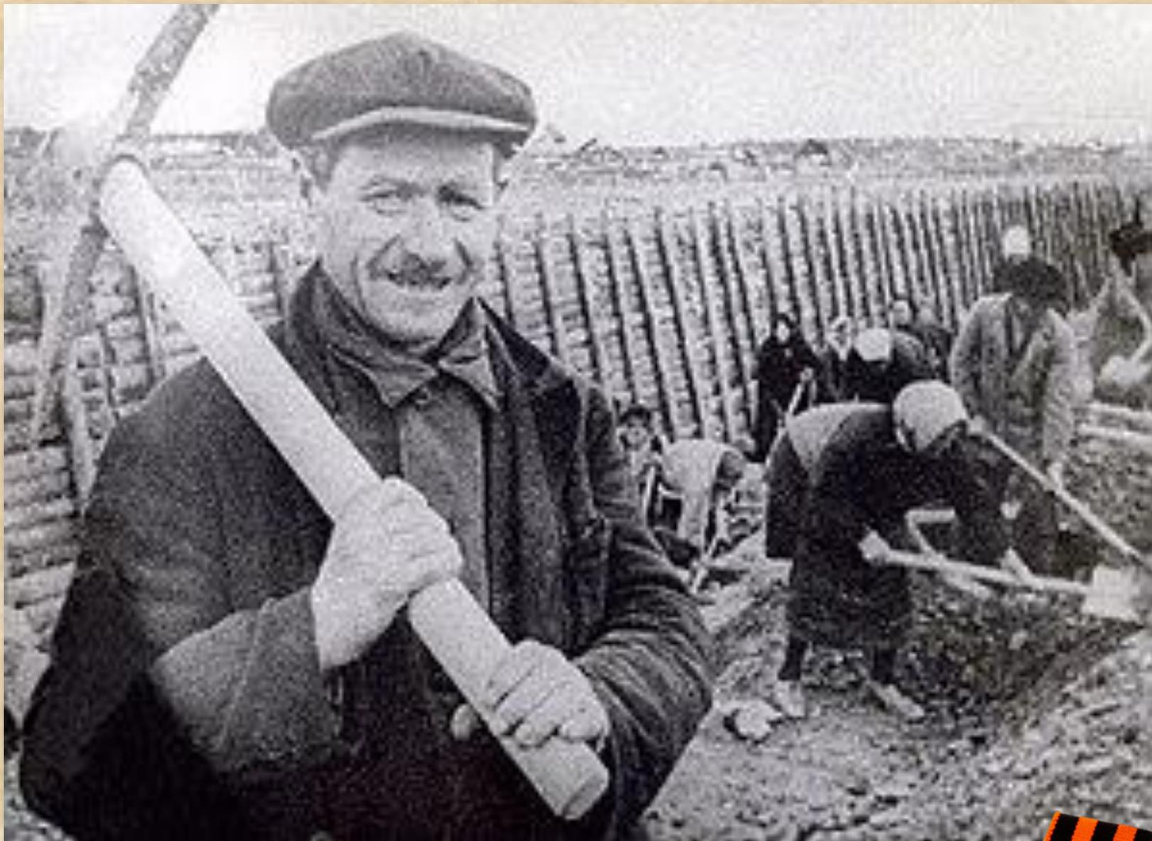
**Техники и инструментов было мало, строители использовали лопаты, топоры, пилы, тележки и пом**
