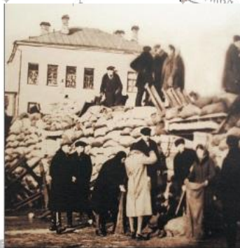
Осень 1941 г. Туляки на строительстве оборонительных сооружений.
