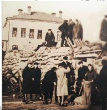
Осень 1941 г. Туляки на строительстве оборонительных сооружений.
