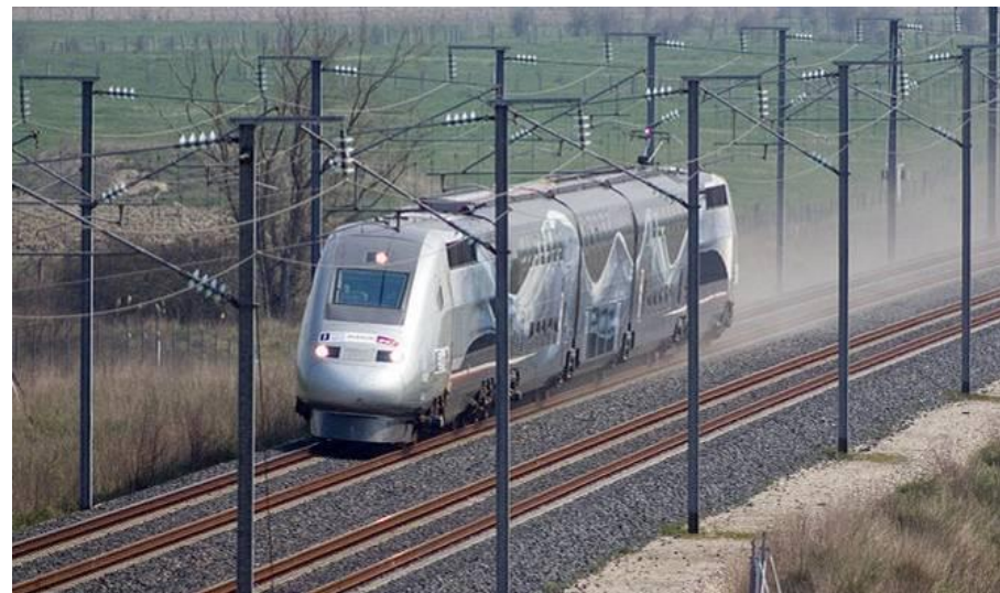
КС переменного тока напряжением 25 кВ
