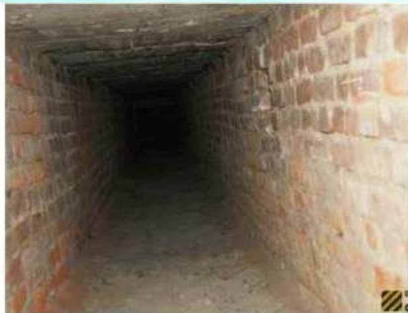
Заглублённая галерея аварийного выхода
