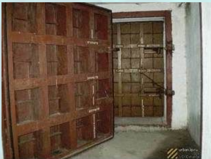
Защитно-герметические (дальние) и герметические (ближние) ворота
