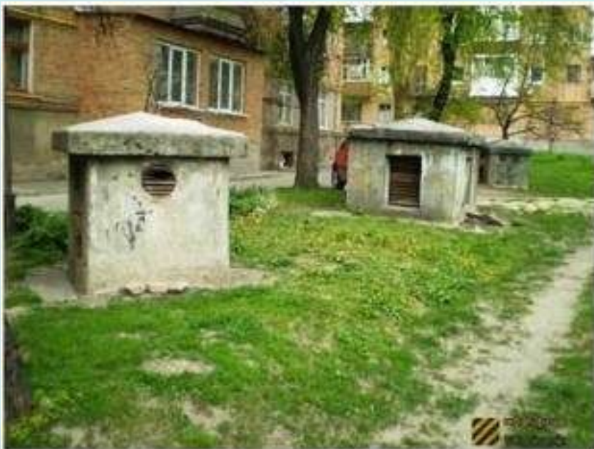
Оголовок аварийного выхода
