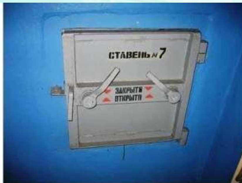
Герметический ставень аварийного выхода
