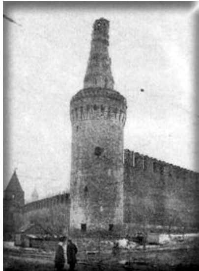
Обезглавленная снарядами Беклемишевская башня
