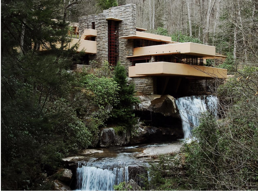
1935 г. Дом над водопадом, Пенсильвания.
