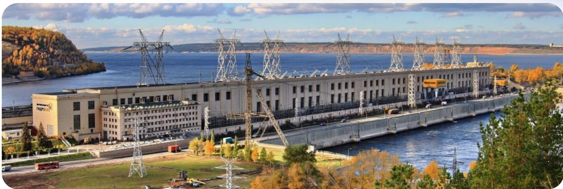
**Гидроэлектростанция (ГЭС)** — электростанция, использующая в качестве источника энергию водных масс в русловых водотоках и приливных движениях.
