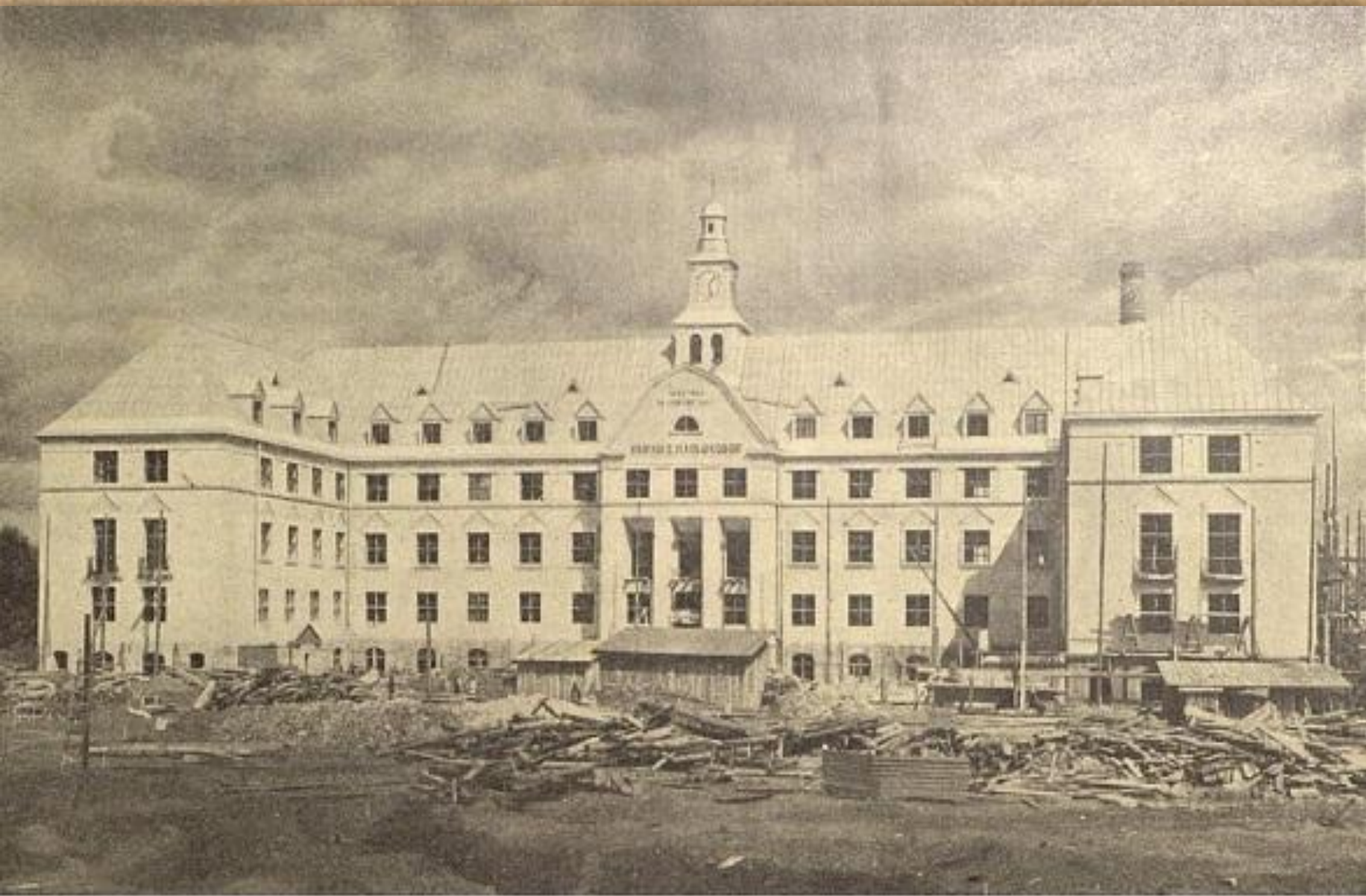
Основное здание ночлежного дома имени Е. И. Мешковой, переданное университету (на стадии завершения строительства)
