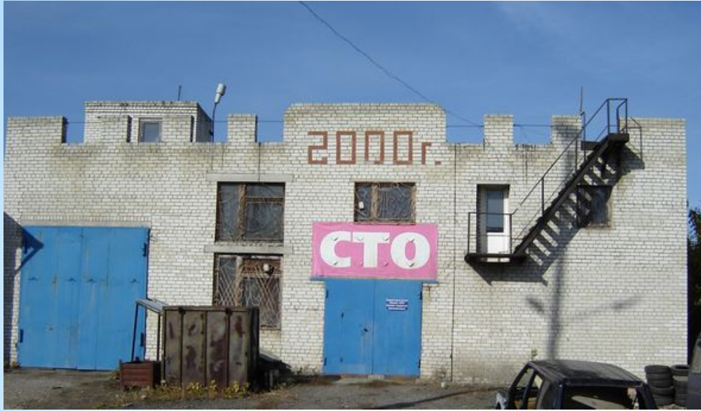
Здание дилерского центра AGCO Офис с сервисной зоной
