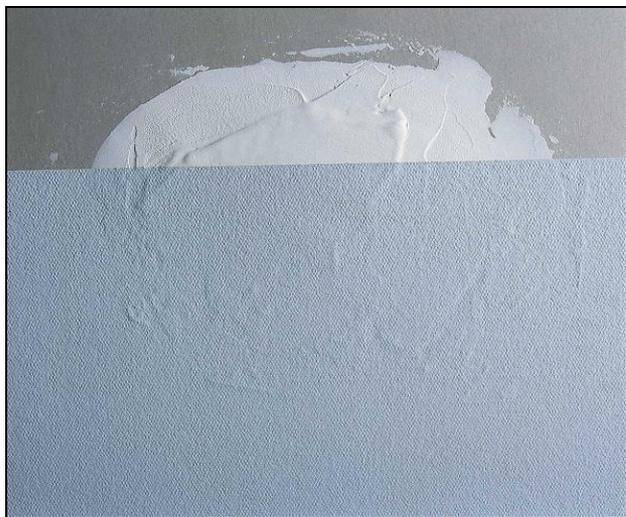
Неудаленные дефекты на поверхности стен останутся видимыми после применения декоративной стеклоткани, особенно при боковом освещении.
