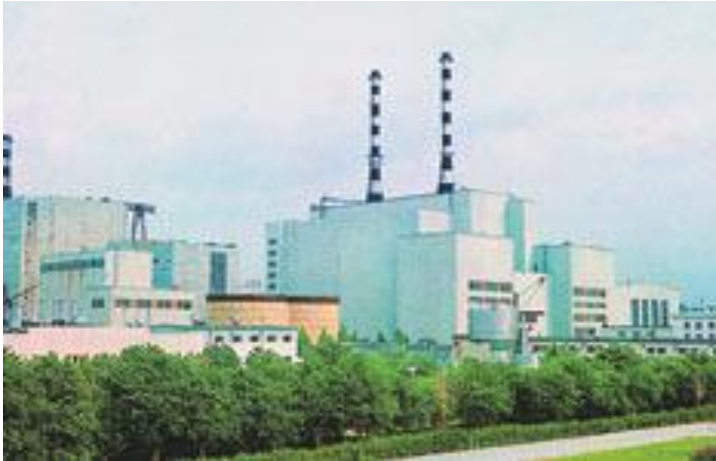
Белоярская АЭС с реактором БН-600
